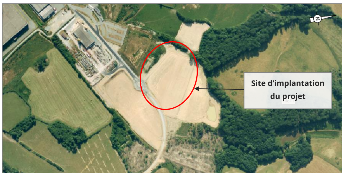
Photographie 12 : Travaux de viabilisation des parcelles de la zone d'activité en 2015 (source : CA du Grand Guéret)
