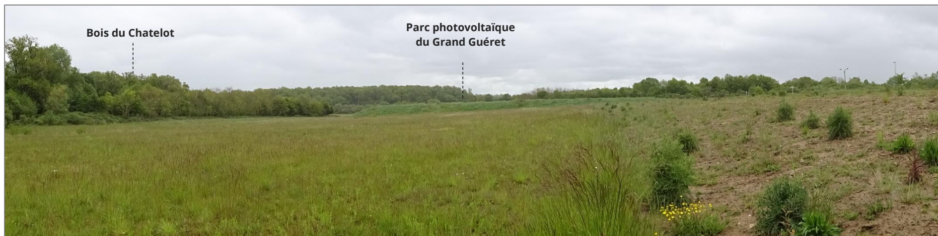
Photographie 4 : Vue depuis l'extrémité sud du site, en direction du nord
