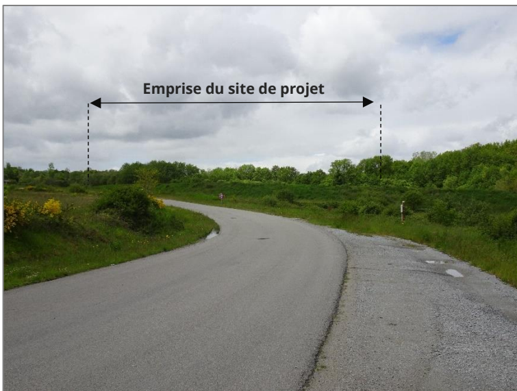
Photographie 7 : Vue vers l'ouest depuis la rue du Cros, au niveau du parc photovoltaïque
